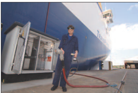
Nach einer erfolgreich verlaufenen Testphase haben Siemens Energy und die Stadtwerke Lübeck am 21. August 2008 Deutschlands erste Landstromversorgung für die Handelsschifffahrt in Betrieb genommen. Die auf dem Nordlandkai des Lübecker Hafens installierte Landstromversorgung versorgt Schiffe während ihrer Liegezeit im Hafen über das örtliche Mittelspannungsnetz umweltfreundlich und wirtschaftlich mit elektrischer Energie.
