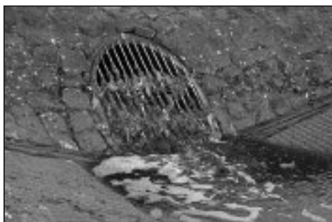
Einleitungsstelle Banter Siel GRUPPO1635_foto.hufenbach
