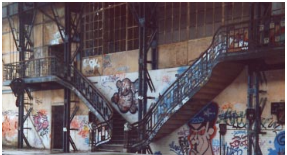
Treppenkonstruktion in der Südzentrale
