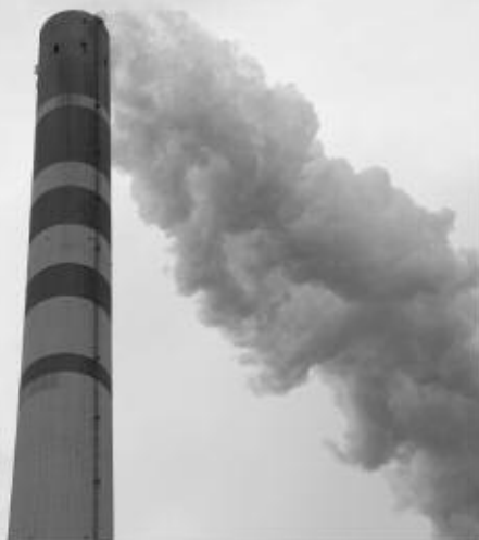
Die Eon Dreckschleuder auf dem Rüsterei Groden, deren Entschwefelungsanlage mindestens zu 30 Prozent im Jahr ausfällt!
